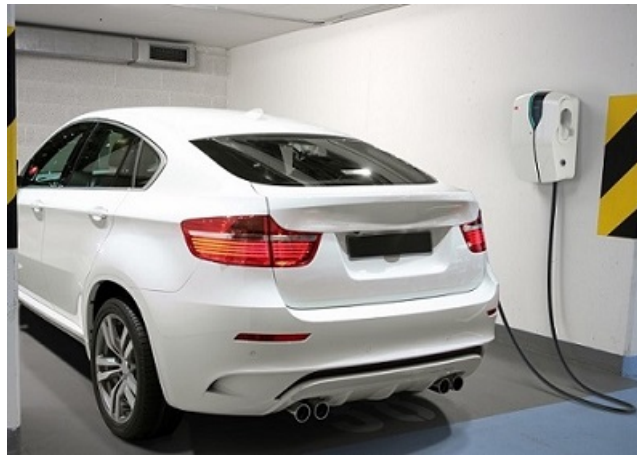
Stazione di ricarica domestica modo 3 - 3,7 kW (ABB)
