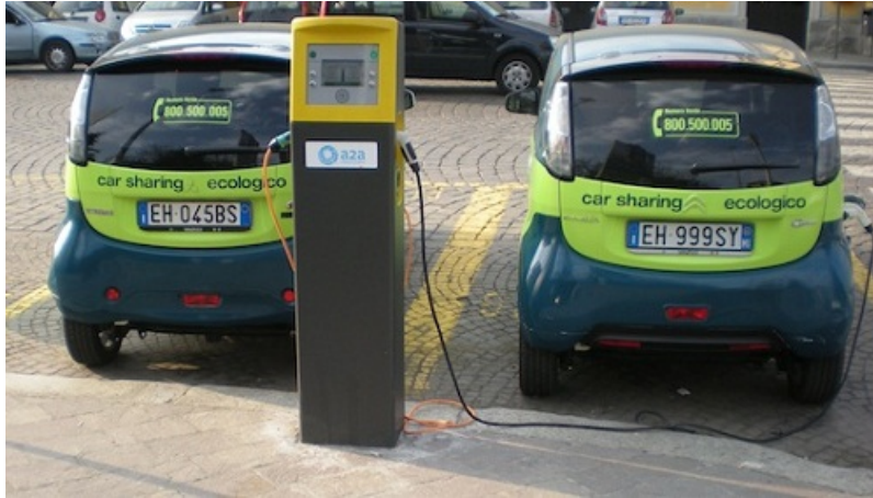
Stazione di ricarica pubblica modo 3 - 22+22 kW (A2A)
