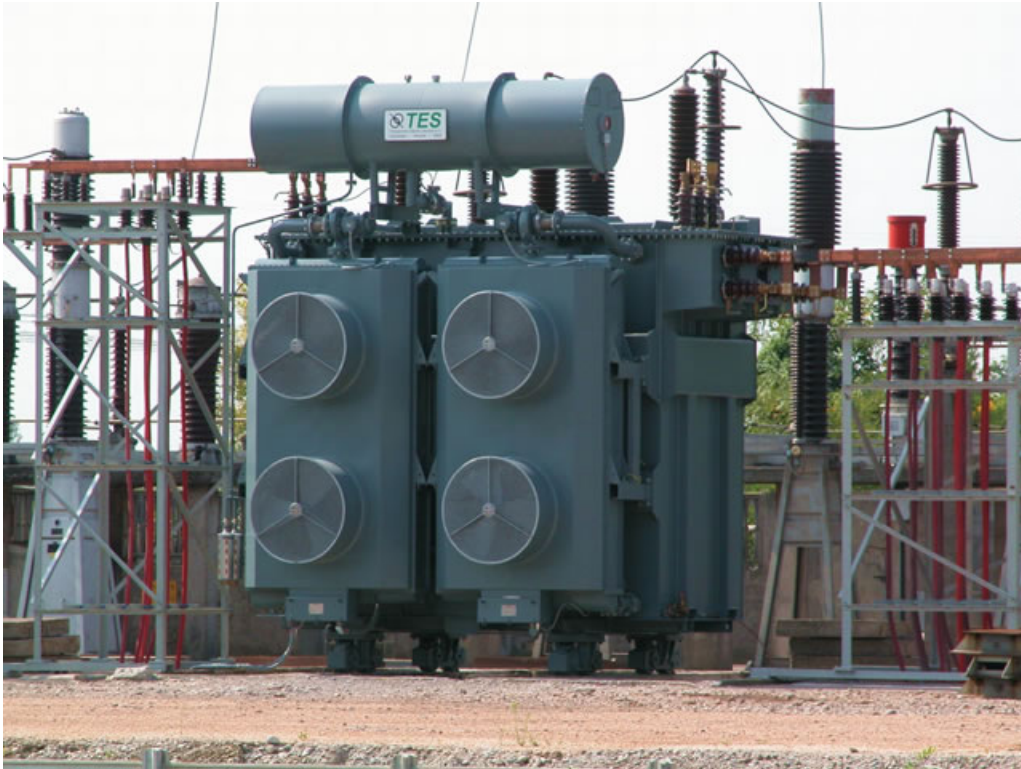
Trasformatore a tre avvolgimenti - TES
