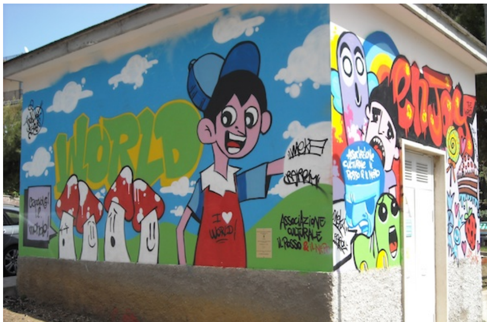
Murales su una cabina elettrica di Civitavecchia
