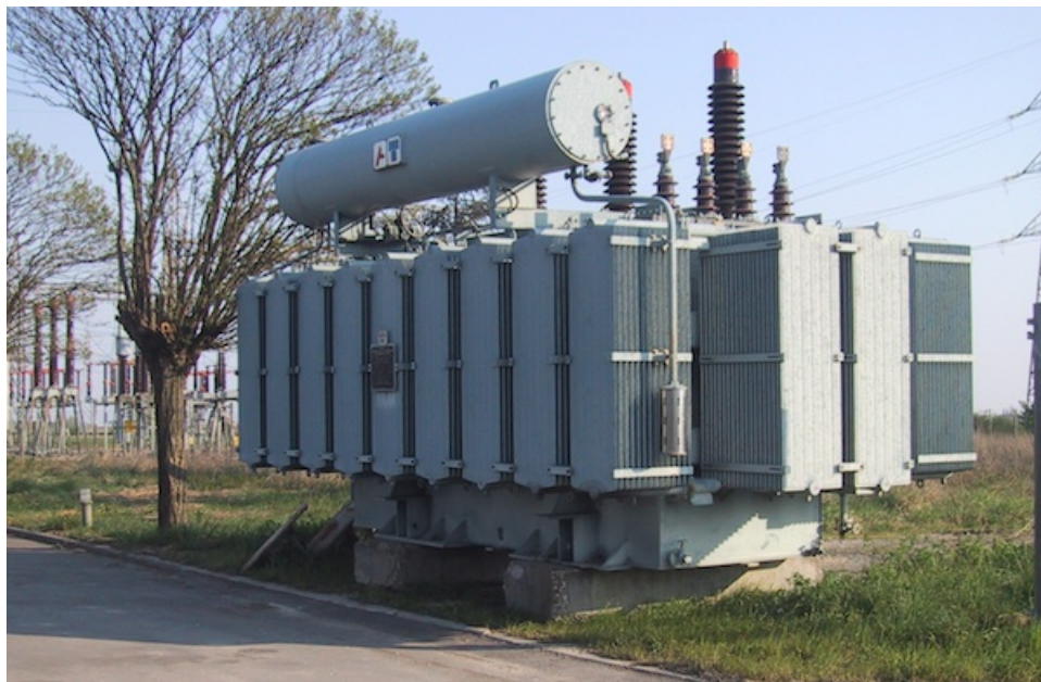
trasformatore AT/MT
