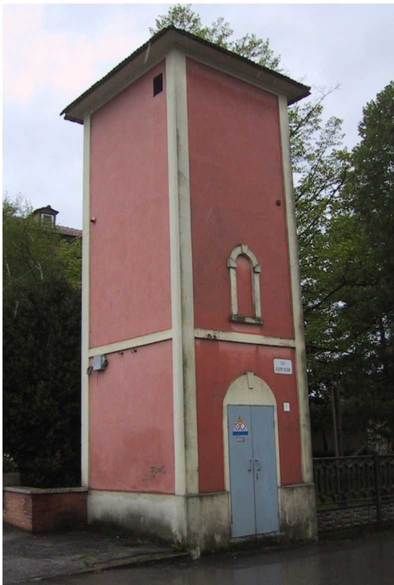
cabina Calto (RO)
