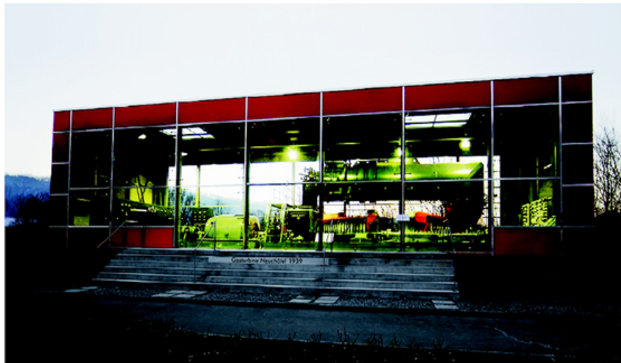
(Turbina a gas di Neuchatel)
