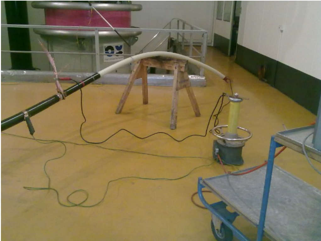
Prove elettriche sul cavo.
