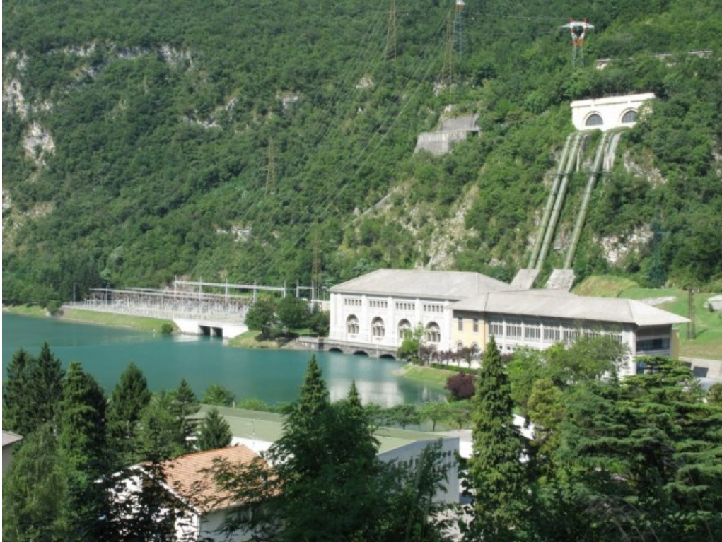
Centrale Idroelettrica ENEL - Nove (TV)
