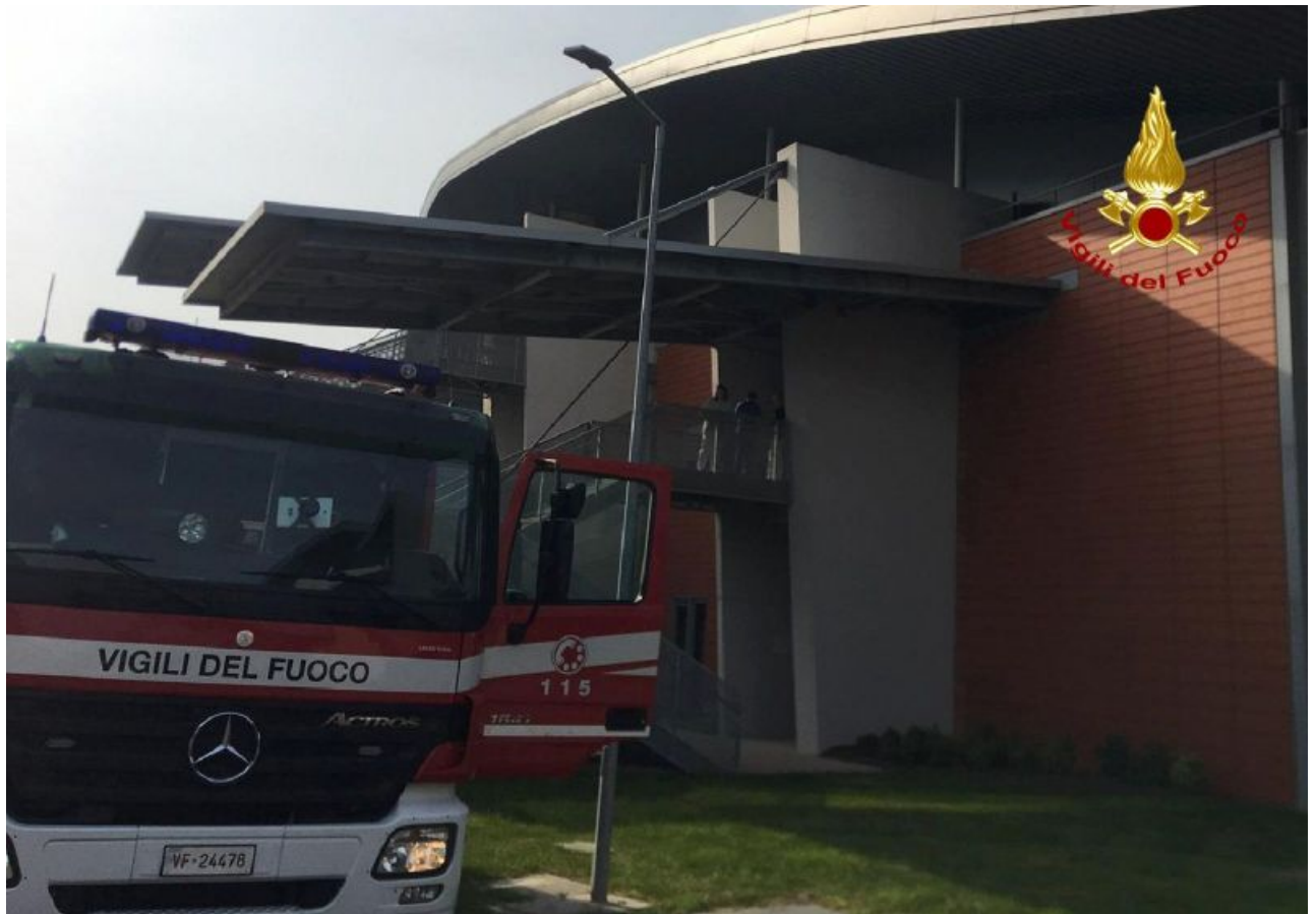
Incendio UPS Ospedale di Monselice (PD)
