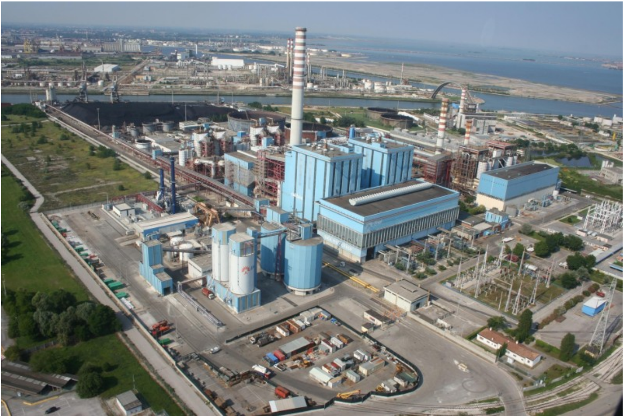
Centrale di Fusina800x600.jpg
