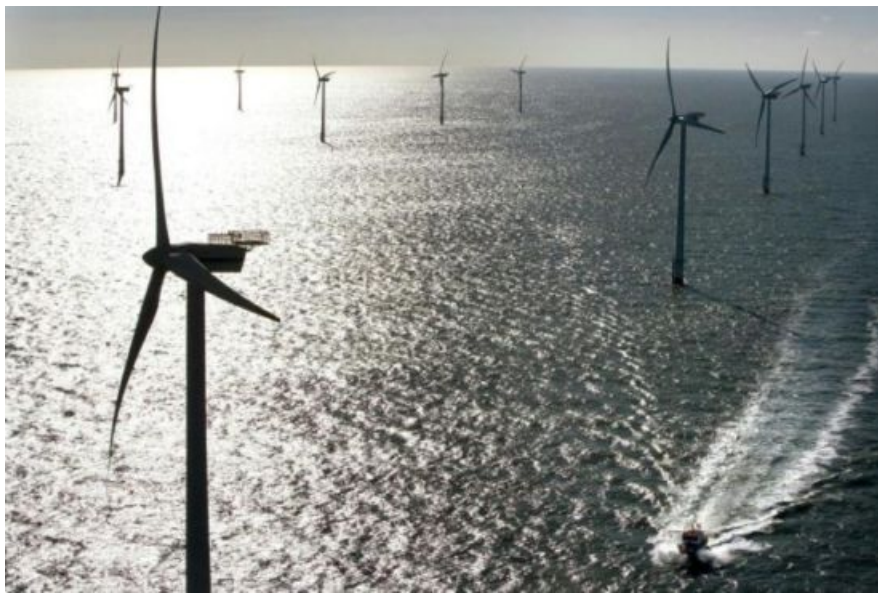
Impianto off-shore di Horns rev (Jutland, Danimarca): 80 turbine da 2 MW ciascuna, produzione di 600 GWh/anno (velocità media \approx 10 m/s)
